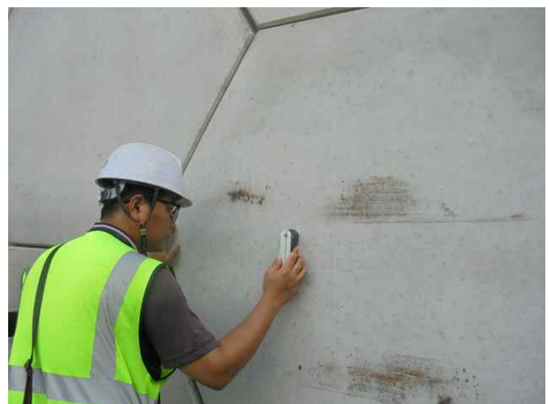
경사계를 이용한 경사도 측정
